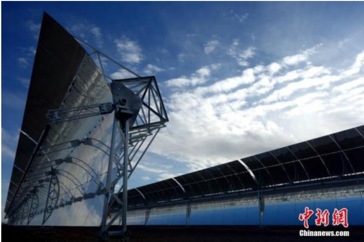
资料图：位于柴达木盆地的中广核德令哈50兆瓦光热发电项目槽式抛物面集热器阵列。中新社记者 孙睿 摄
